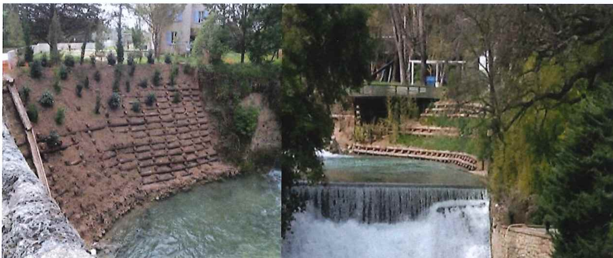
Figure 1 : Réalisation de caissons végétalisés – SIA Nartuby 2013
